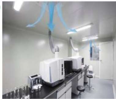
Imagen 14 Sistema de flujo de aire en un laboratorio de biotecnología. Recuperado de
